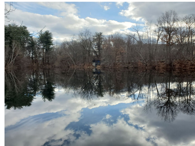
Vista del embalse Upper Van Horn mirando río abajo con presa y aliviadero de hormigón al fondo
